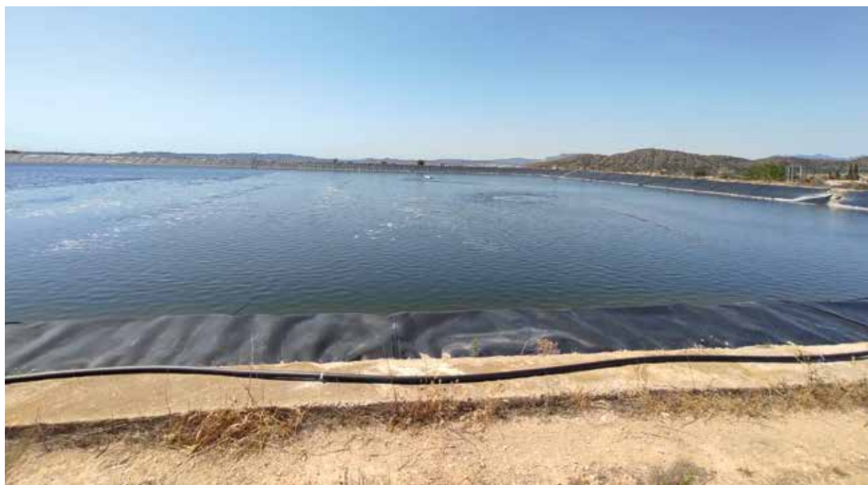
Figura 2 Balsa con sistema de aireación profunda
