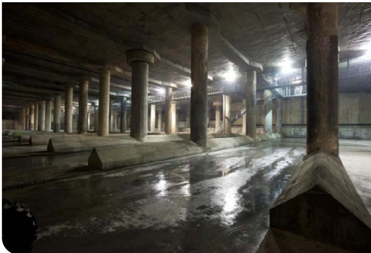
Tanque de tormentas de Arroyofresno (Madrid) Capacidad: 400.000 m 3 Dimensiones: 22 m altura. 36.000 m 2 área. 2 niveles. El tanque de tormentas dispone de obra de llegada, así como sistemas de limpieza, ventilación e impulsión al colector de margen derecha, a la E.R.A.R. de Viveros y colector de margen izquierda según necesidades
