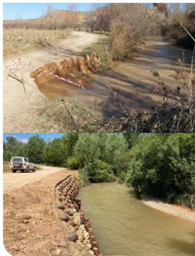
Figura: Refuerzo del margen del cauce con entramado vegetal tipo Muro Krainer. Río Júcar en Ademuz (Valencia). Foto arriba: antes de actuación. Foto abajo: actuación ejecutada.
