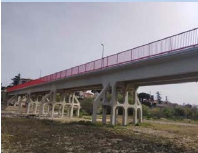
En buen estado de conservación Puente de Eugenio Ribera. 1/04/23
